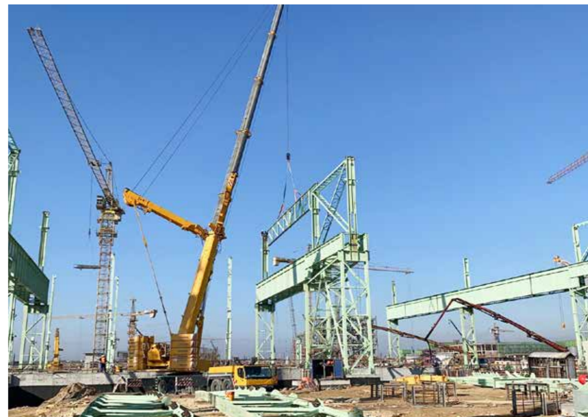
项目进入设备安装阶段
